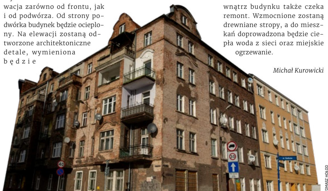
Narożny budynek przy ul. Ptasiej 30 jest jednym z ostatnich, którego elewacja wymaga remontu
