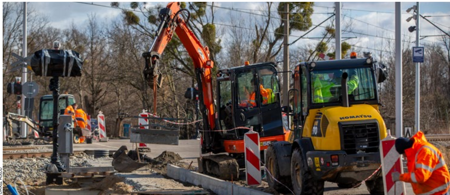
W styczniu rozpoczęły się prace, powstała podbudowa chodnika. Teraz robotnicy BRUKPOL-u rozpoczęli przebudowę jezdni
