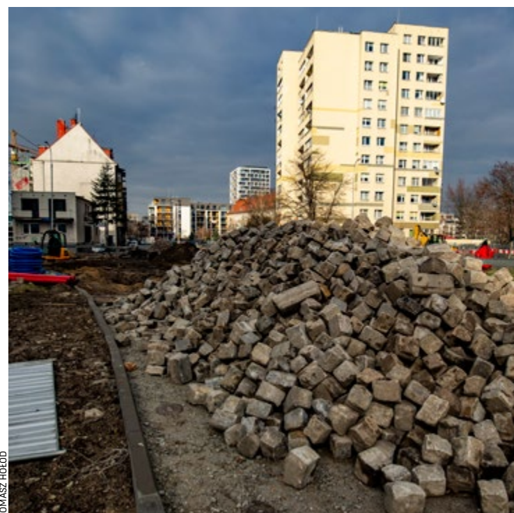
Powstaje 470 m brakującego chodnika po stronie zachodniej
